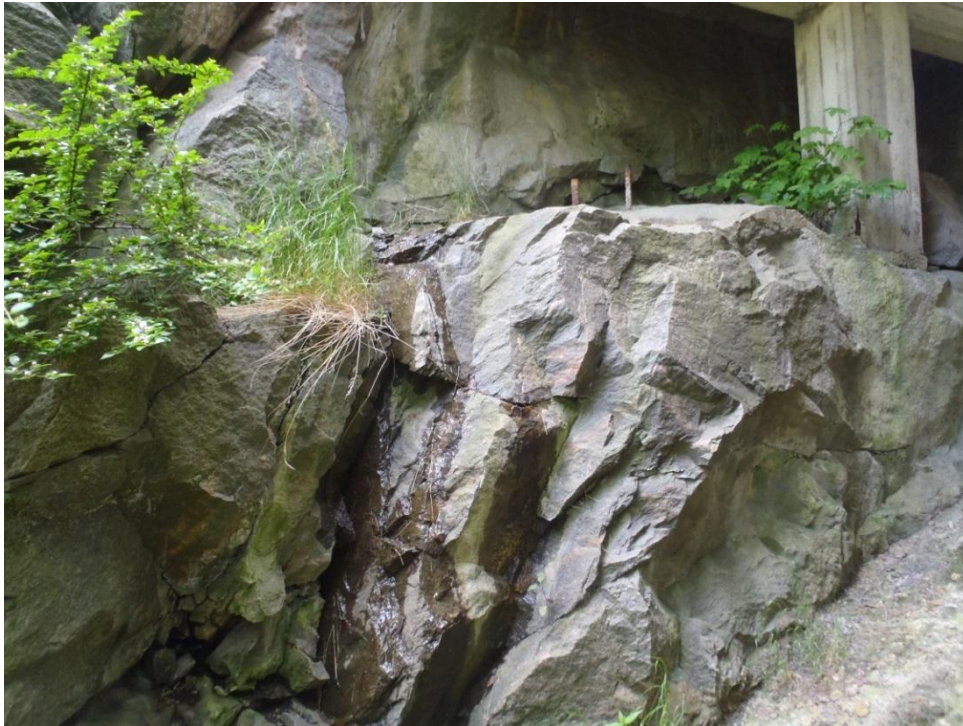
Figur 8: Slänten i Figur 6 fotograferad närmare. Branta sprickplan med stöd i botten.
