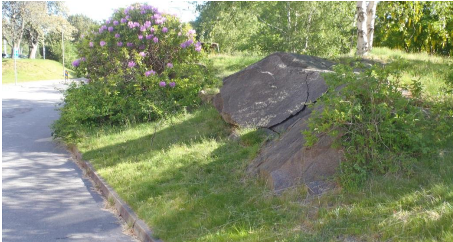
Figur 27: mindre bergskärning i mitten av skolans gård med ett löst block.
