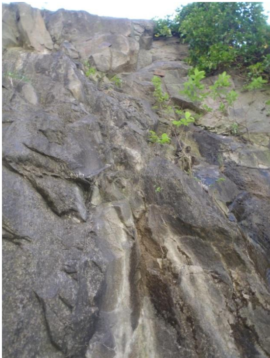
Figur 11: den branta bergslänten vid Friskis & Svettis-husets södra sida. Berget är nästintill massformigt.
