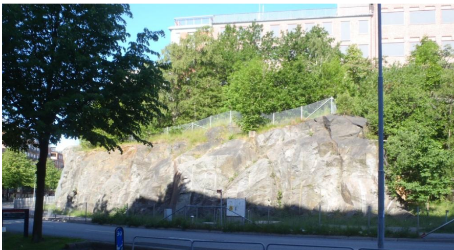
Figur 23: Bergslänten ut mot Östra Eriksbergsgatan.
