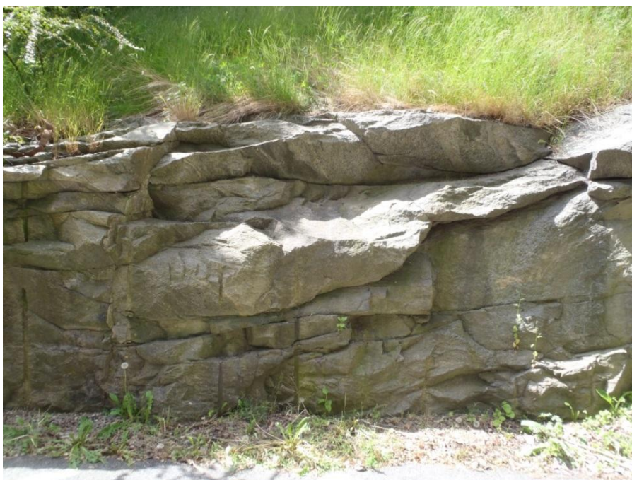
Figur 5: låg skärning vid Friskis & Sveltis-husets lastkaj på västra sidan av huset. Spricksystem med subhorisontella sprickplan.
