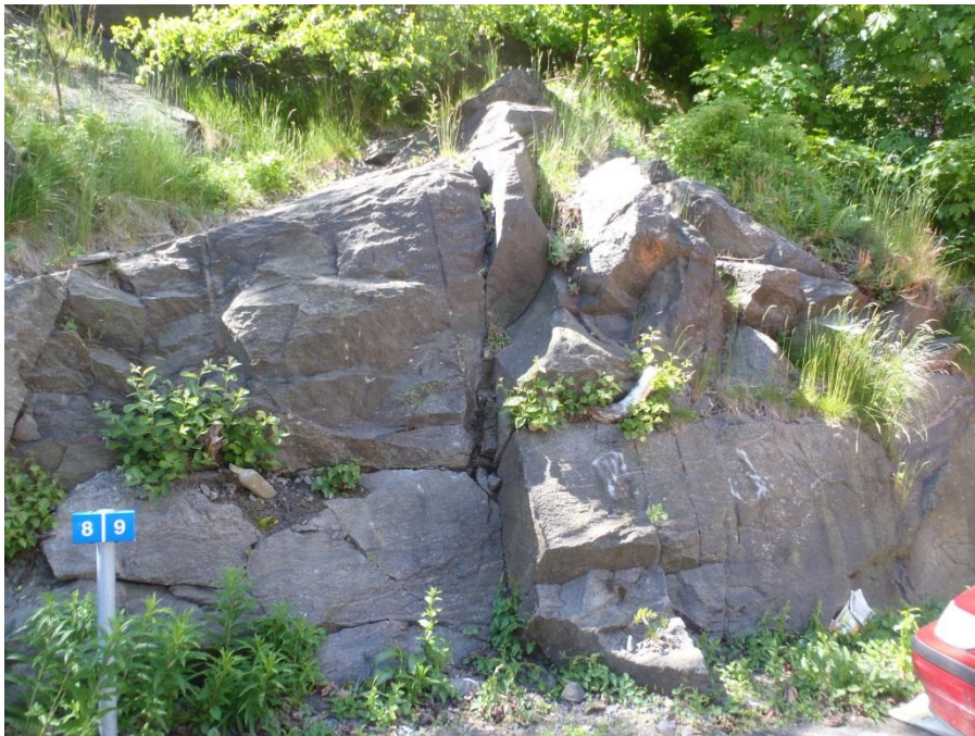
Figur 25: Subvertikala spricksystem vid parkeringen längs Östra Eriksbergsgatan i område 3.
