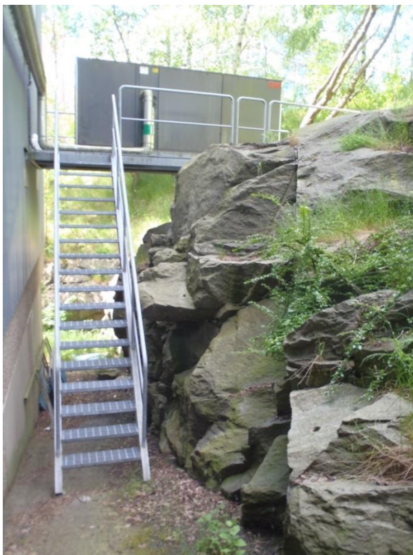
Figur 6: bultad bergslänt på baksidan av Friskis & Sveltis-huset (fotograferat mot sydväst). Spricksystem är dels subvertikala (syns tydligt i bild) och stryker öst-västligt, dels mer flackt lutande vilket skapar blockighet. Slänten är bultad.
