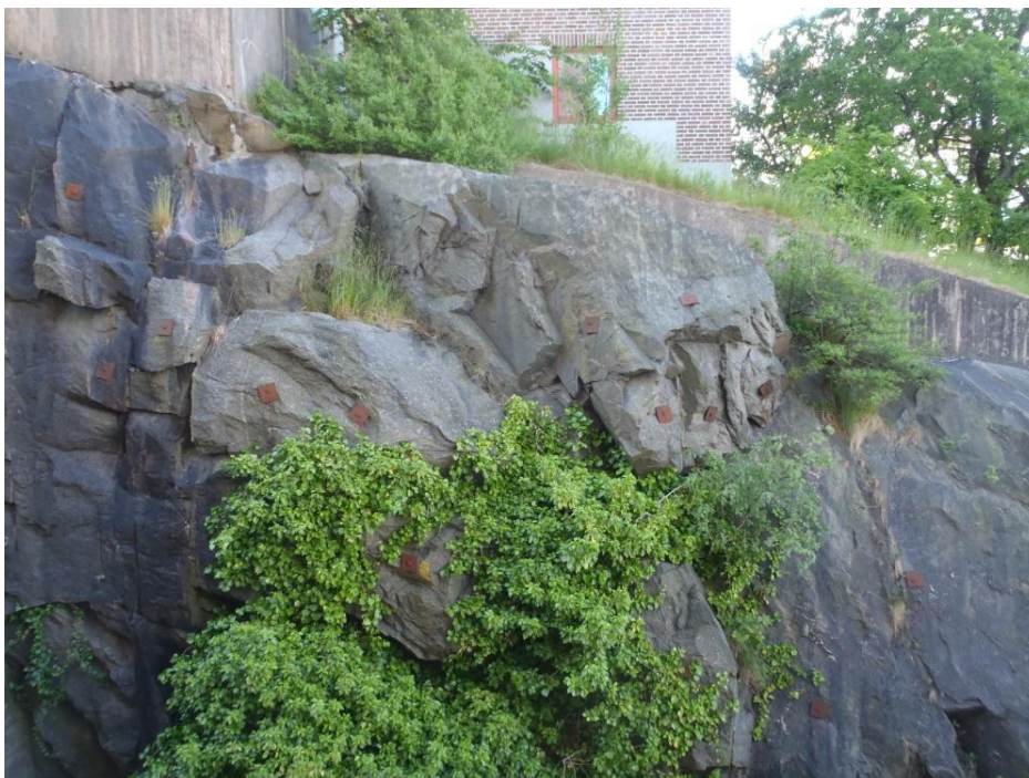
Figur 12: den branta bergslänten vid Friskis & Svettis-husets södra sida. Slänten är bultad, främst i de övre delarna.
