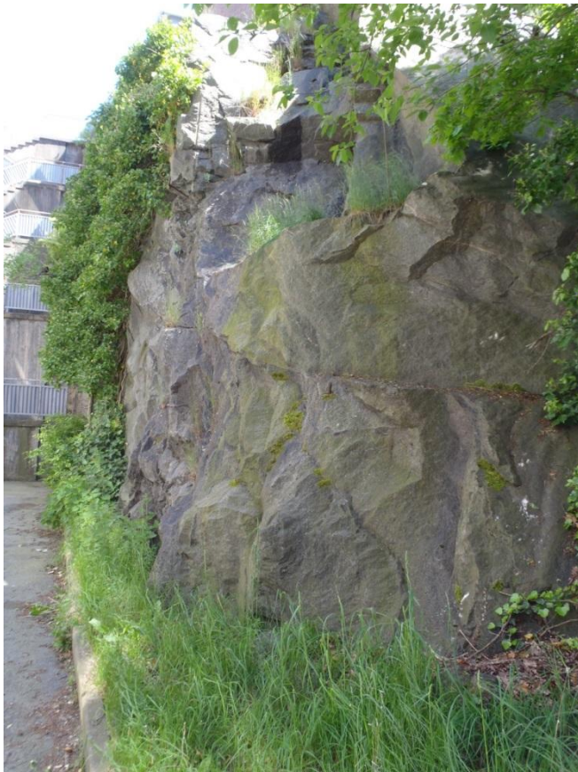
Figur 9: brant bergslänt vid Friskis & Svettis-husets södra sida. Nästintill massformig granitoid med fåtal sprickor, som är täta.
