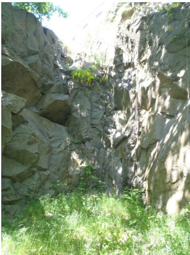
Figur 19: brant bergslänt bakom två servicebyggnader längst söderut i område 2.
