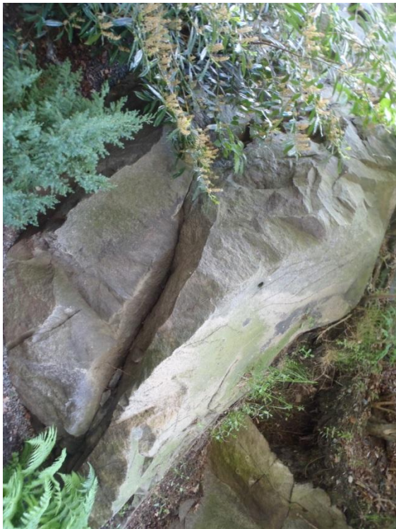
Figur 16: blockighet i slänten och rik växtlighet. Detta block är bultat.
