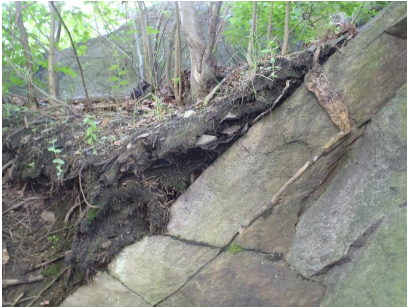
Figur 18: en tillplattad rot som vuxit i en öppen spricka.
