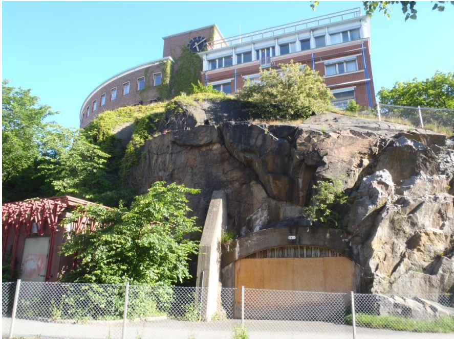
Figur 22: brant bergslänt vid ingång till bergrum vid Östra Eriksbergsgatan.
