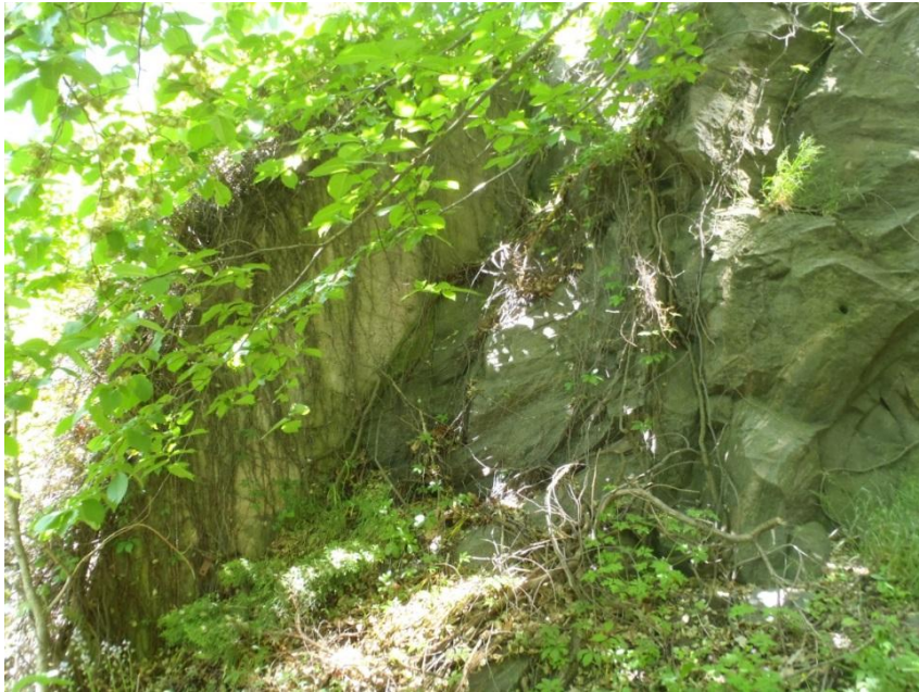
Figur 21: bergsläntan bakom de två servicebyggnaderna, med en äldre stödmur och med bultade block. Rik växtlighet.
